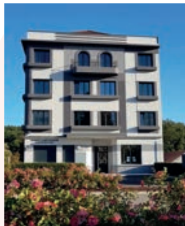
Avril 2021 — Livraison de deux logements et d'une maison de santé à La Vôge-Les-bains. Maîtrise d'ouvrage déléguée.
