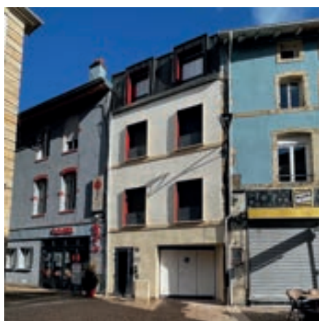
Décembre 2021 — Restructuration lourde de trois logements en centre ancien, accompagnant l'OPAH-RU « Épinal au cœur » lancée par la ville d'Épinal, rue de la Maix. Partenaires : État, Banque des Territoires, Ville d'Épinal, Action Logement.
